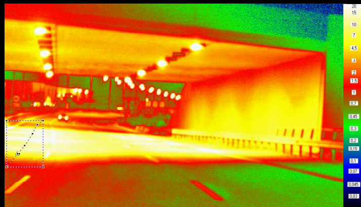
Γέφυρες Αττικής Οδού
